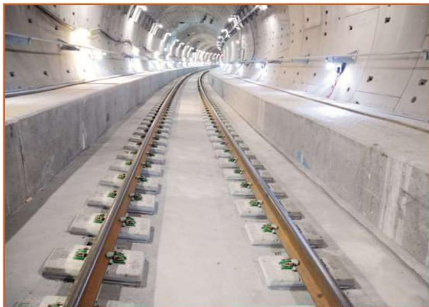
Рис. 1. Система Low Vibration Track (LVT)
