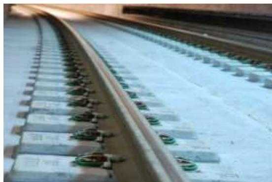
Рис. 1. Безбалластная конструкции верхнего строения пути с низким уровнем вибрации
